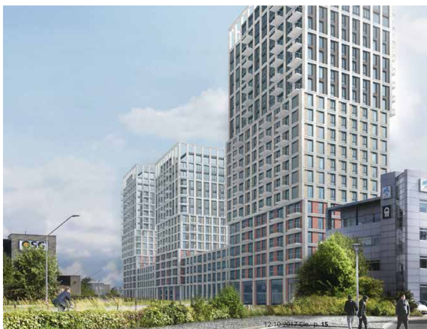
Het Dok, 314 middenhuurwoningen, NDSM-terrein, Amsterdam
