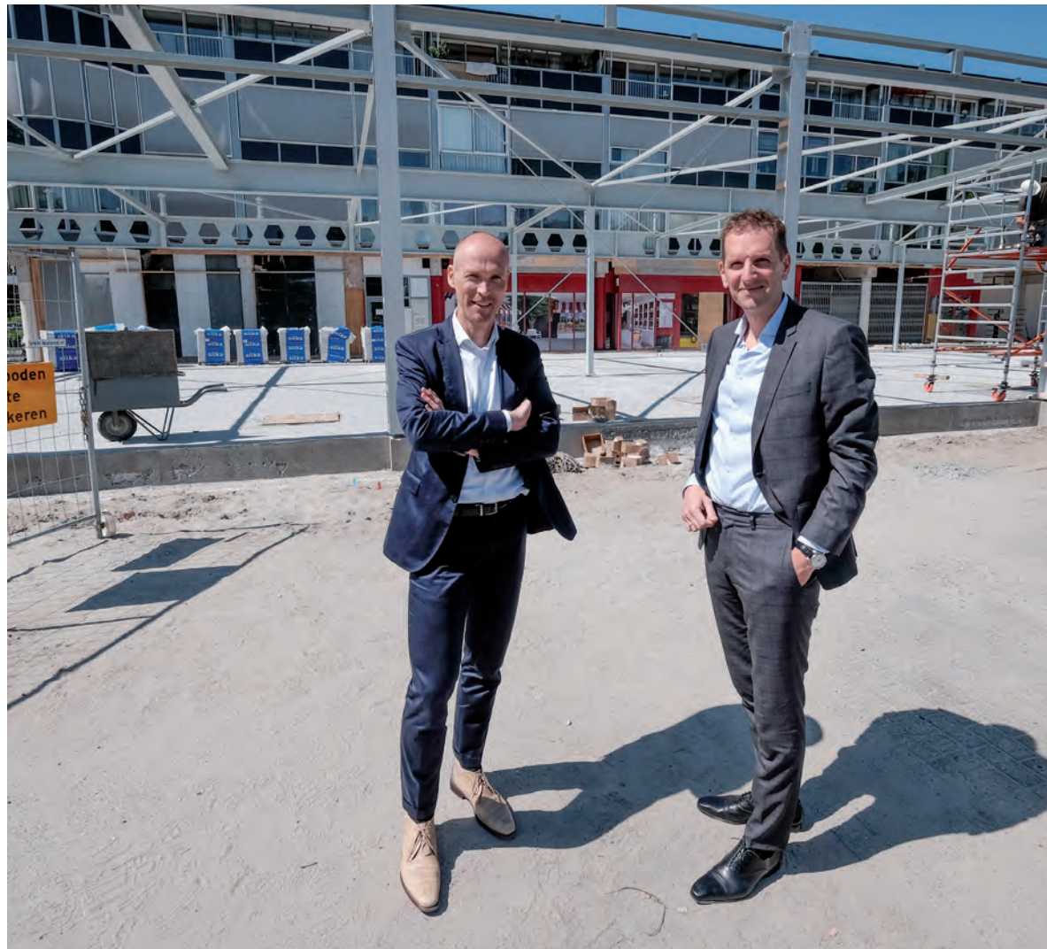
Wim-Jaap Eising en Collin Boelhouwer voor de staalconstructie van de nieuwe Dirk van den Broek supermarkt
